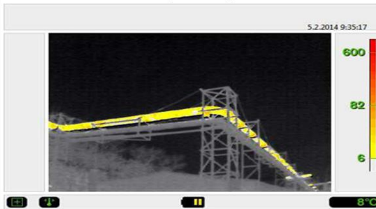
Stav před opravou
